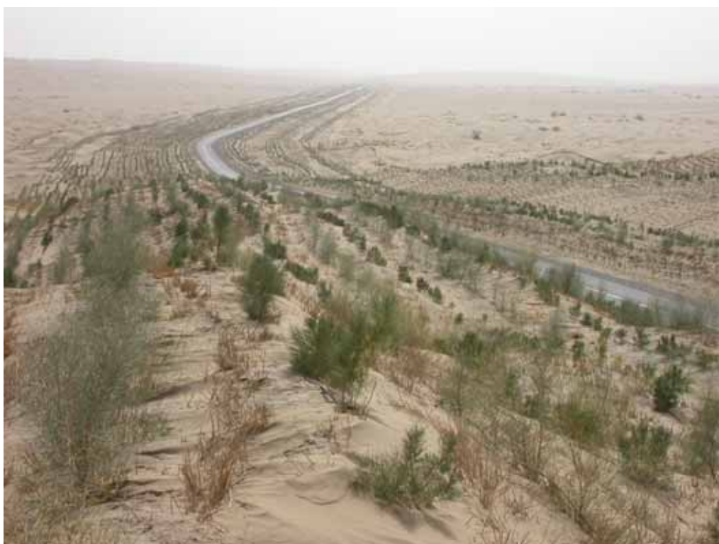
砂漠公路の緑化。草方格で砂の動きが沈静化すると、タリフ類や加力 カ カ 類等を植栽してゆく。 (新疆ウイグル自治区輪台～民豊 2004.10.12 撮影)
