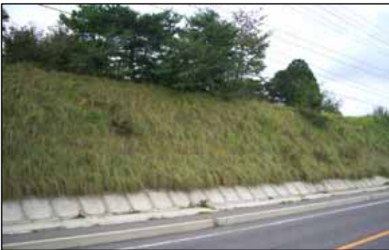
写真 - 1 ウィーピングラブグラスで緑化した法面
