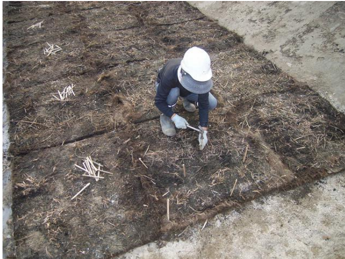
オギのマット状苗を現場に固定している状況。 出水などで流出しないように杭で固定している。
