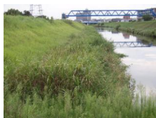
写真-2 施工から1年半が経過した状況
