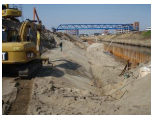
写真-1 施工状況
