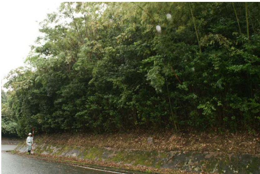
常緑広葉樹と落葉広葉樹の混交林形成を緑化目標とした国内産在来種播種工による法面緑化事例。低木層をシャリンバイが優占する植物群落が形成されている（熊本県・施工16年後）。
