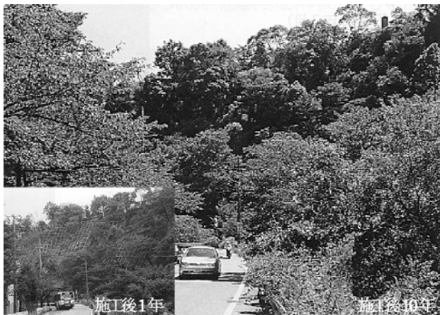
写真-1 フリーフレーム工法 施工後状況
