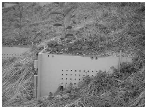
写真-1 簡易法面植栽柵「エコプランター」
