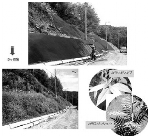
写真-1 マザーソイル工法
