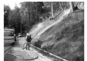
徳島県でTS工法 周辺ドングリ導入
