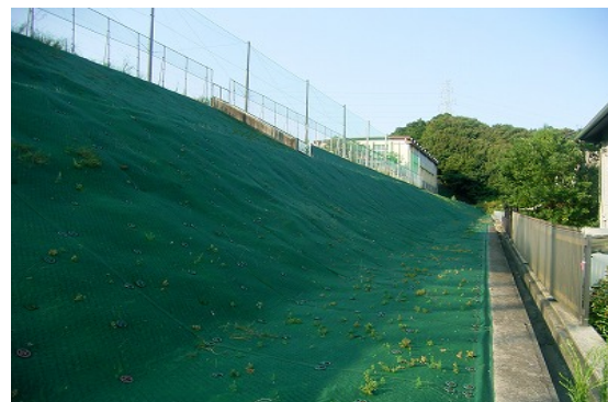
写真-2 1年経過状況（全景）
