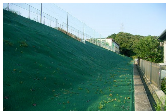
写真-2 1年経過状況（全景）
