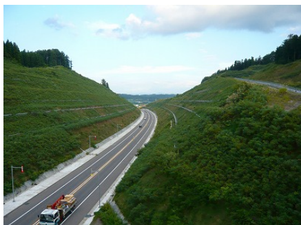
写真-2 伐採材のリサイクル事例
