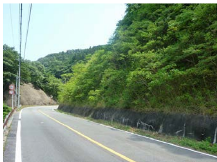
写真-1 既設モルタル吹付面の再緑化事例
