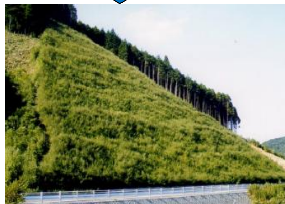
植物誘導吹付工施工2年
