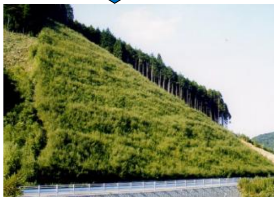
植物誘導吹付工施工2年
