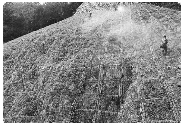
写真-3 静岡県榛原郡 グリッドフレーム150 施工例 (吹付前)
