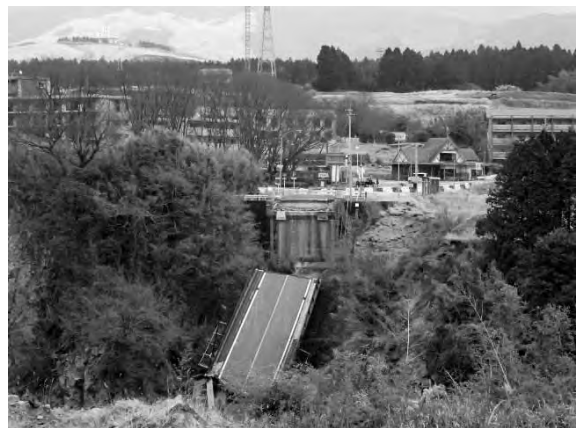
写真 5 国道 325 号阿蘇大橋の崩落
