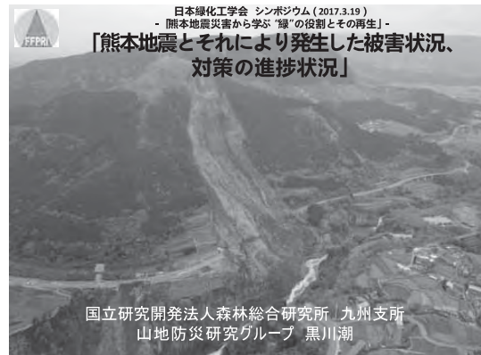
図1 熊本地震により発生した大規模な斜面崩壊（阿蘇大橋地区）
