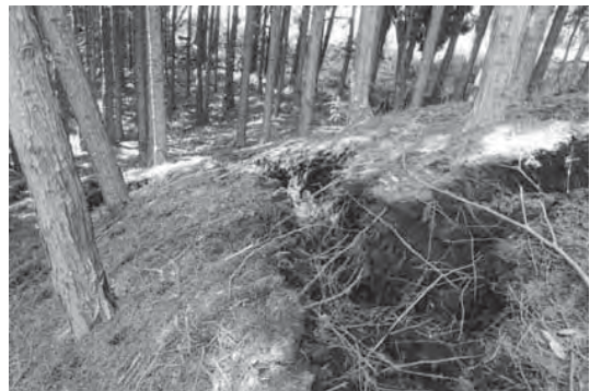
図4 斜面上部における多数の亀裂（火の鳥温泉）
