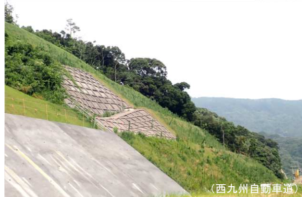
(西九州自動車道) 植生工の施工完了後1年程度経過した植生
