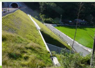
植生工施工後の法面（東九州自動車道）
